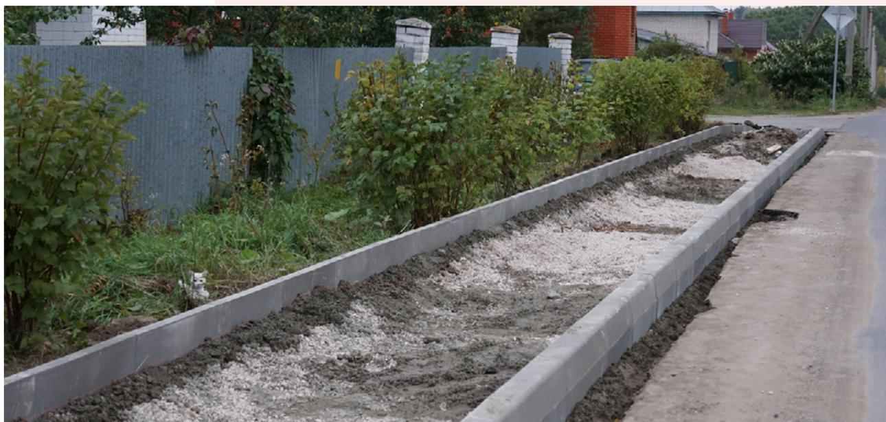
Рисунок 2. Строительство тротуаров
